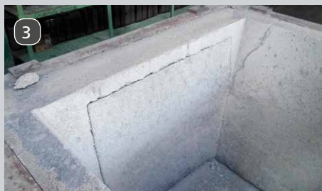
3 \ Impact area with precast pieces after 3 years working Tolva de carga tras 3 años de trabajo
