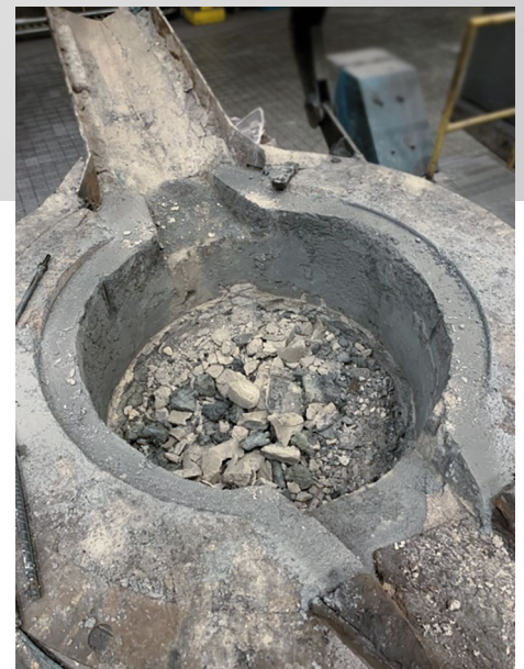
\ Reparaciones con FASTON
