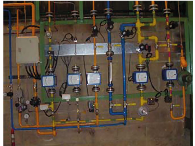
\ Panel de gases para atmósfera sintética típica ( \text{N}_2 + \text{CH}_3\text{OH} ) con opción de añadir \text{NH}_3 .
