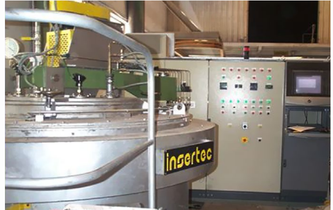
\ Horno de pote, con detalle del sistema de control.
