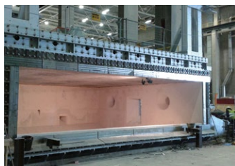
\ Revestimiento completo horno reverberero en hormigón refractario
